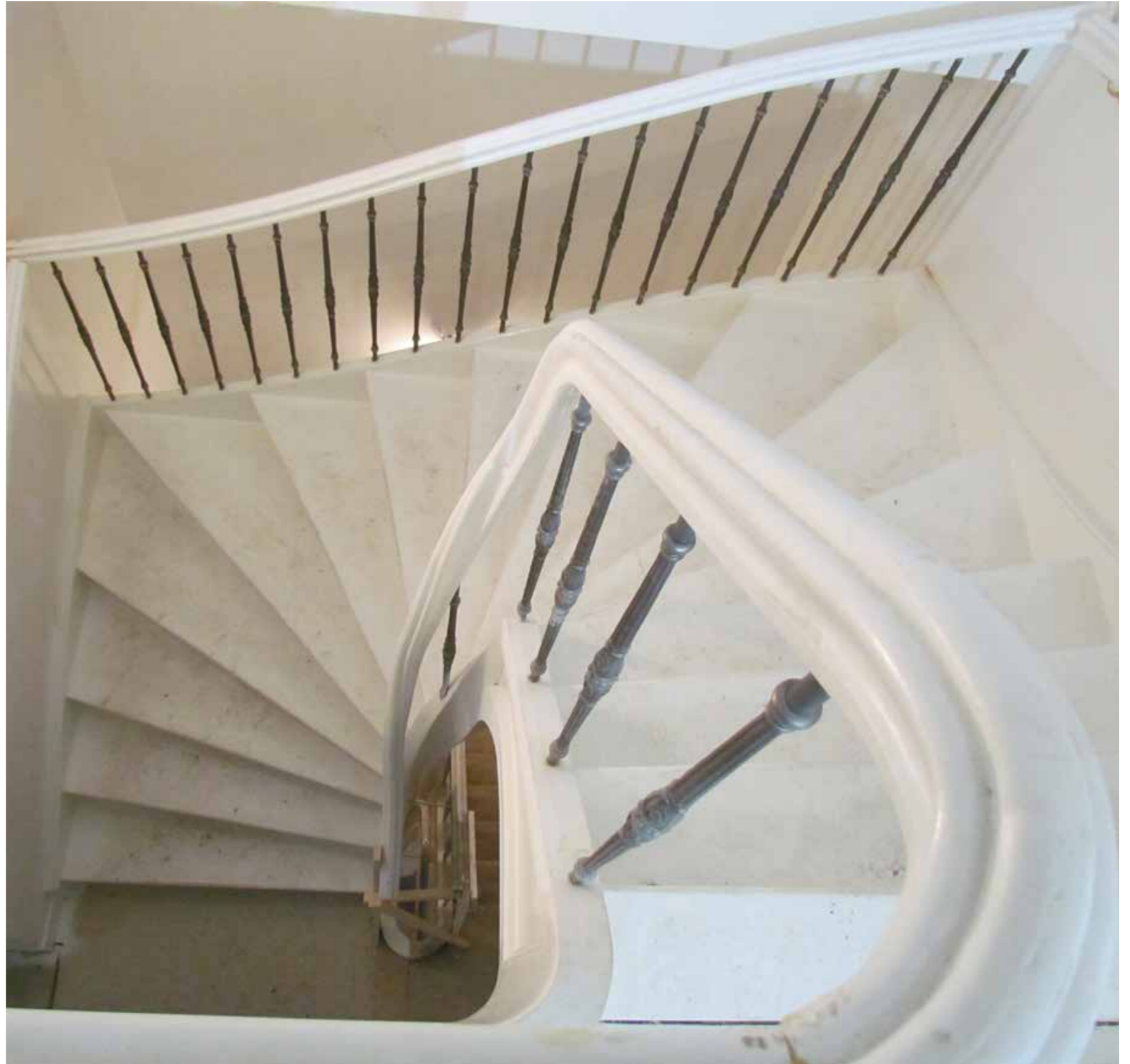
Renovatie & Restauratie pand aan de IJsselkade - Zutphen
